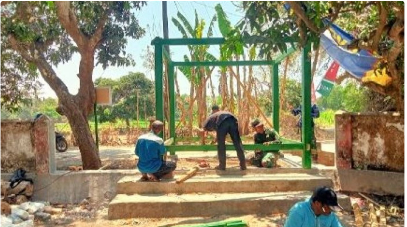
Pengerjaan Poskamling oleh Satgas TMMD Ke-118 Kodim 0829/Bangkalan di Desa Patengteng Kecamatan Modung
