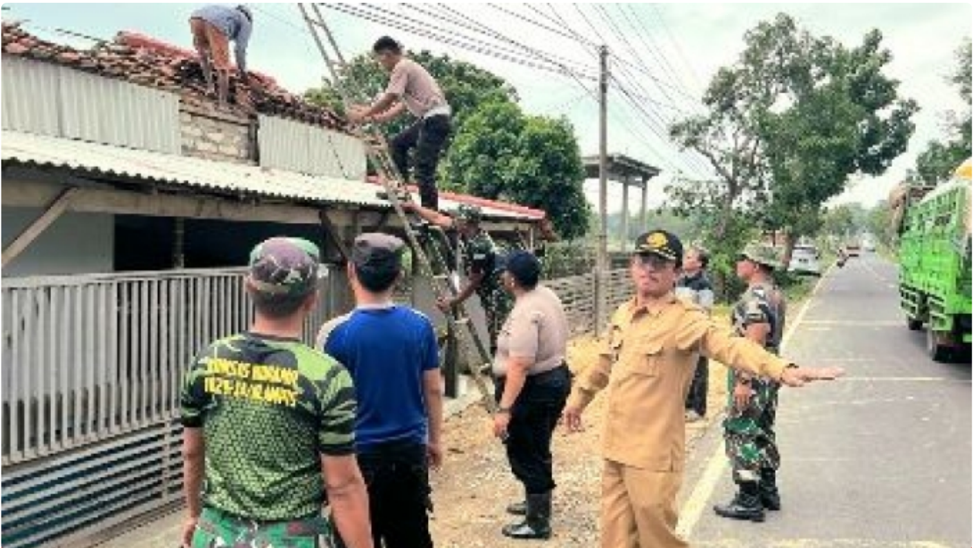
Karya Bakti perbaikan rumah terdampak robohnya tiang listrik.
